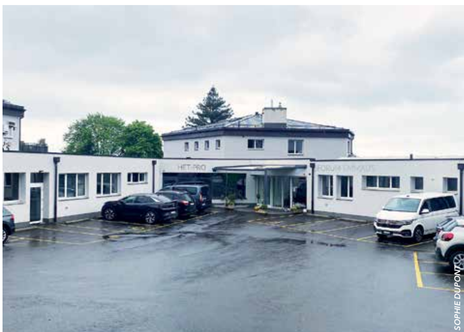
Entrée de la HET-PRO
